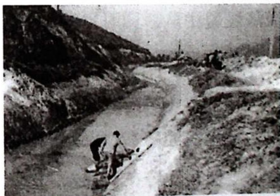
图 3.6 封堵渠堤水涌
