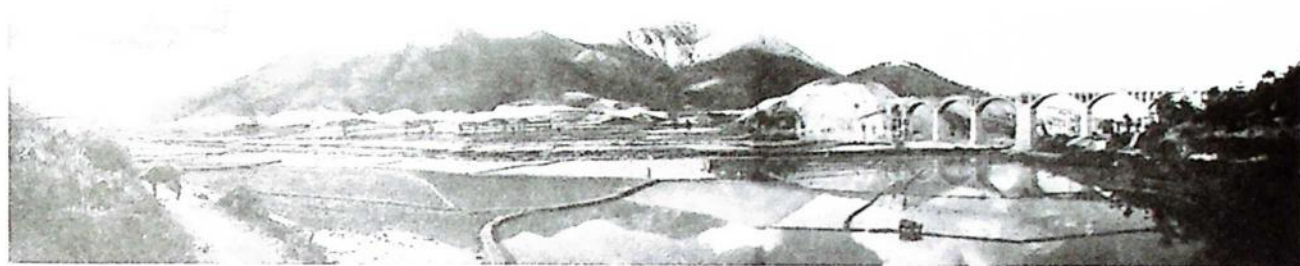
图 1.7 石字、下墩与水尾引水渠汇流于石牌渡槽
