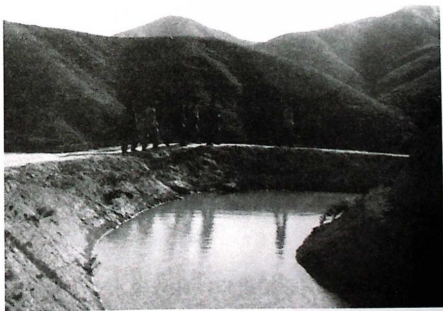
图 1.4 水尾引水渠一角
