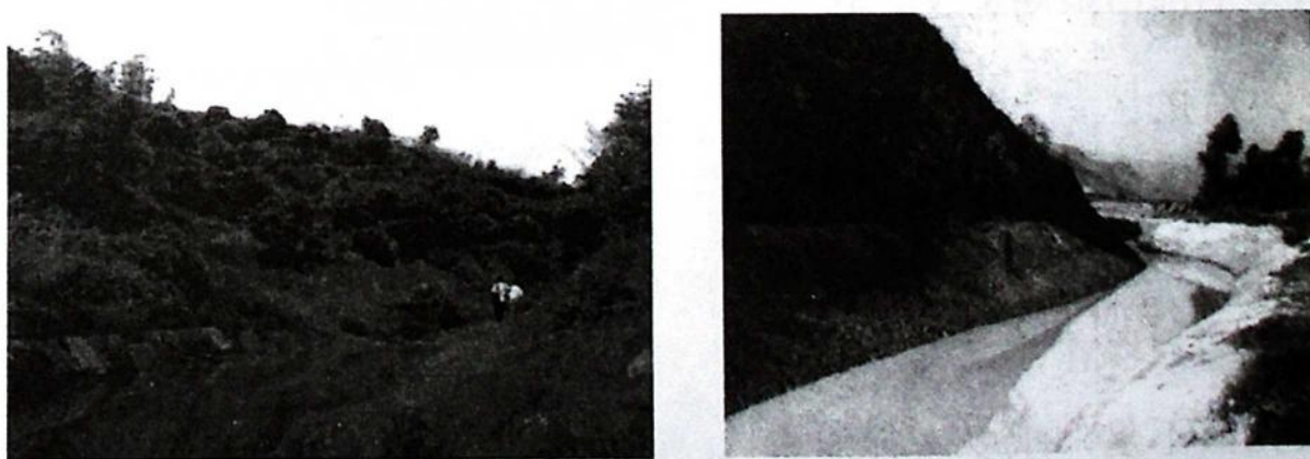
图 3.4 昼夜巡渠查险
