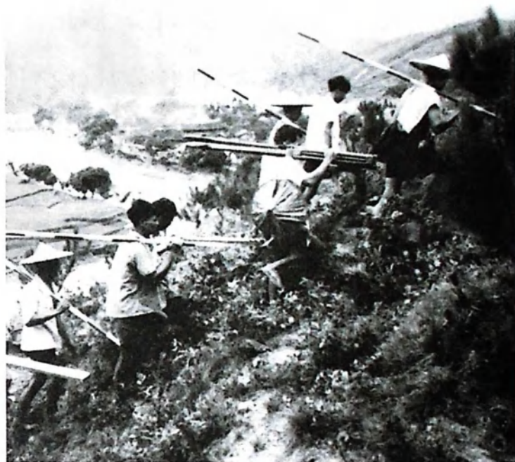
图 2.2 翻山越岭勘测渠线
