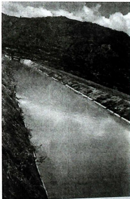
图 3.16 风吹岭制水厂进水口
