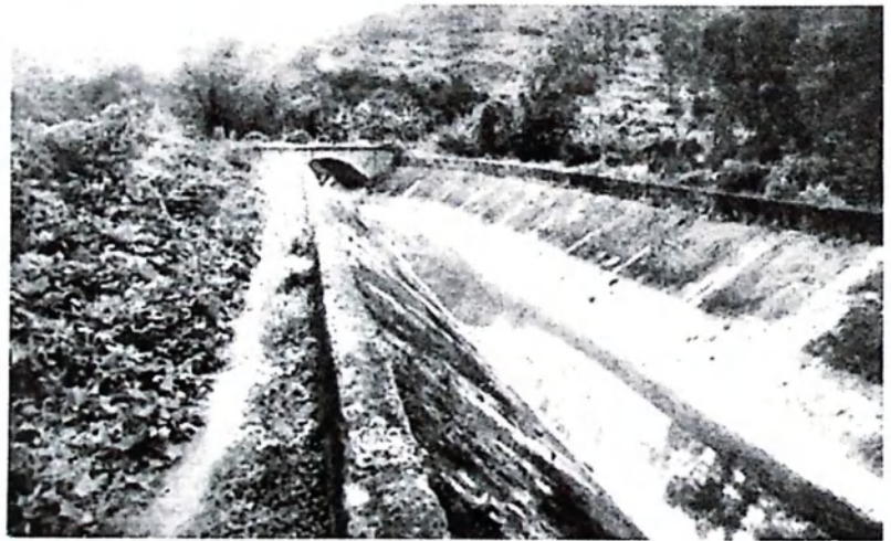
图 3.23 水患难防的马鞍岭高填方
