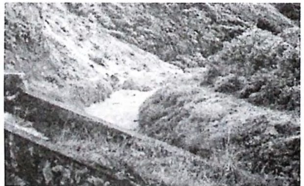
图 3.22 坑头渠段坍塌堵渠
