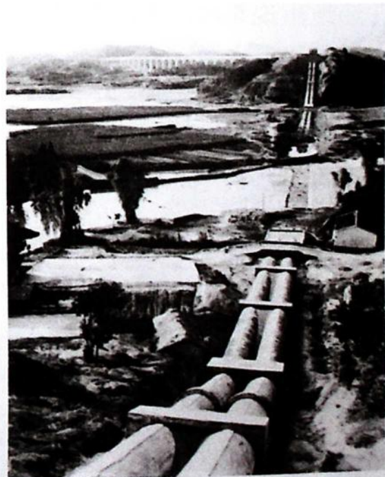
图 3.18 上窖倒虹吸管工程
