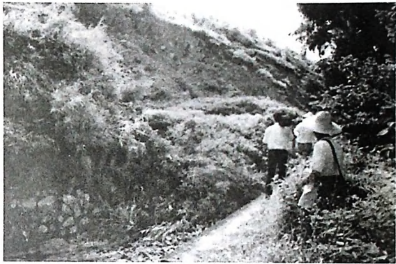
图 3.17 滑塌渠坡堵截渠水
