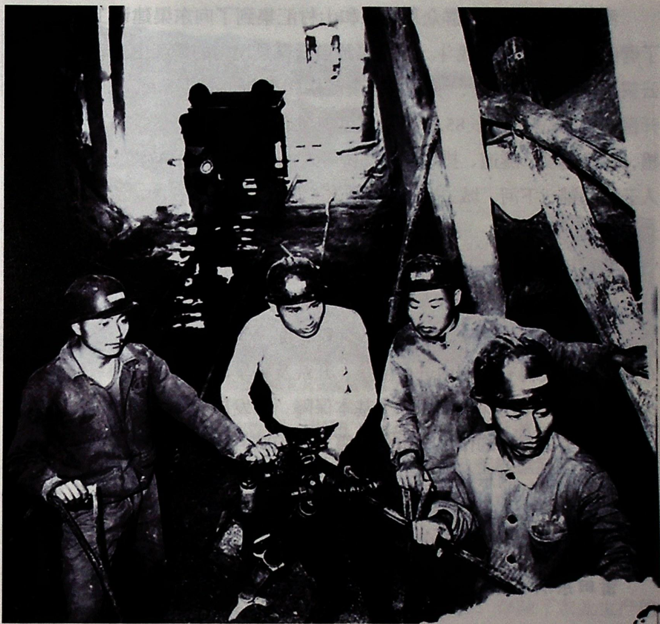
东山县民工团在水尾隧道中紧张施工
