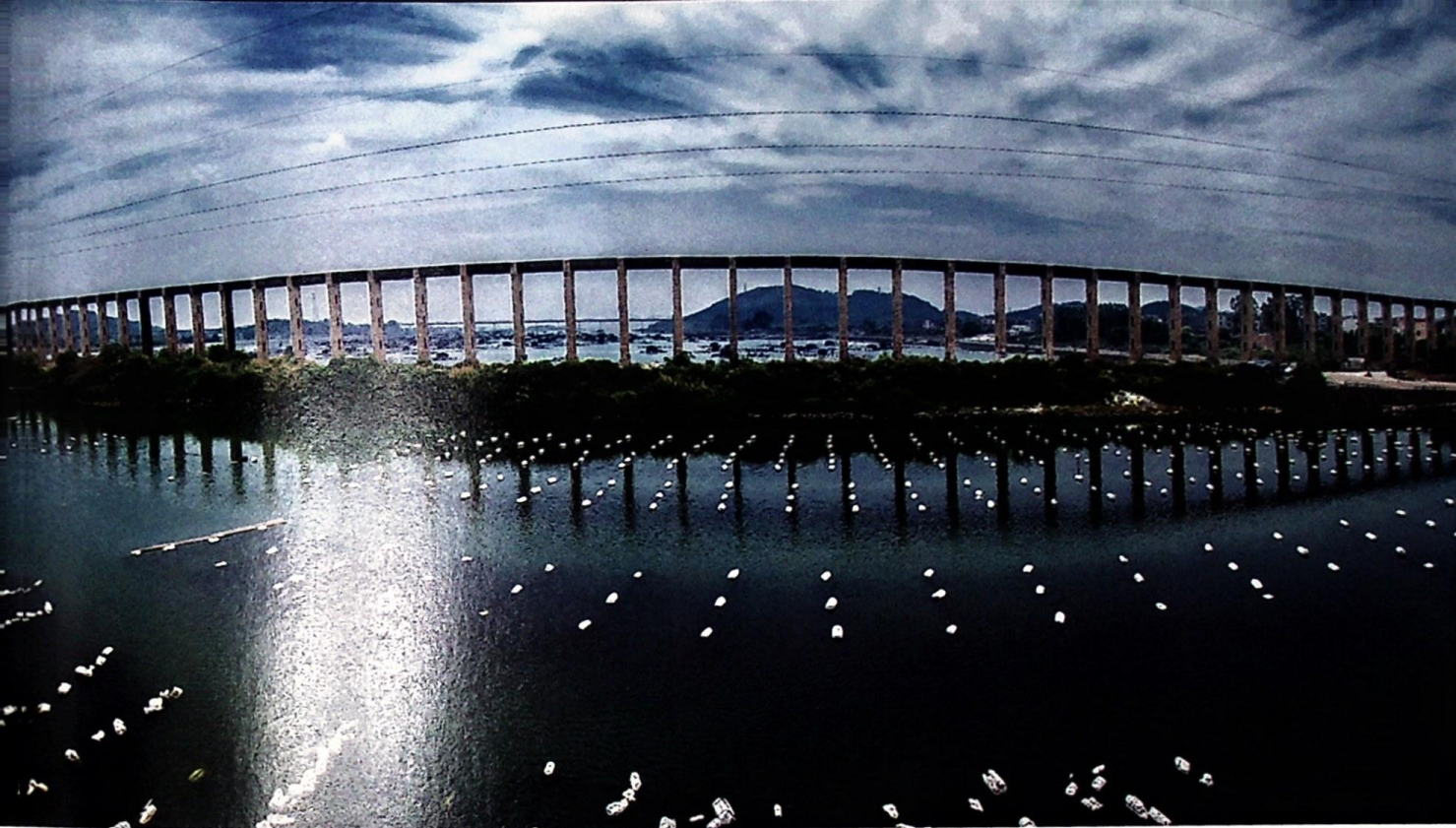
云霄向东渠八尺门渡槽 李全文 摄
